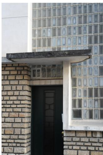
*Moellons de pierre finition en bossage avec joints creux au ciment, façon de panneaux dans le corps d'un enduit sur béton, auvent et encadrement de baie en béton, grand panneau en pavé de verre.*
