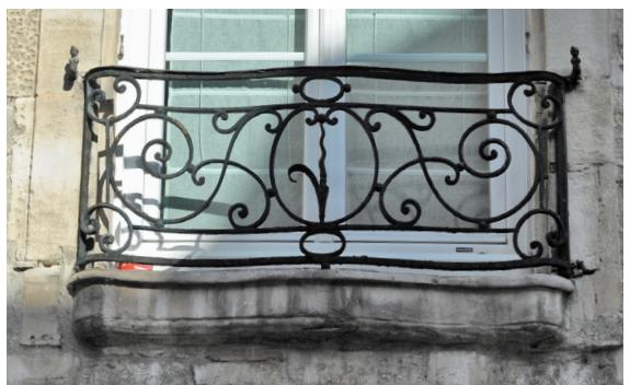
Garde-corps façonné en suivant l'ondulation de l'appui de fenêtre ; le motif central comprenait une double feuille en tôle, plus fragile, l'une d'entre elle a été cassée et a disparu.
