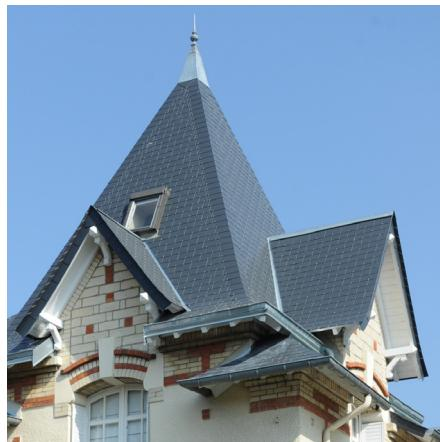
Couverture ardoise et éléments de charpente débordants des toitures complexes fréquentes dans le style Eclectique.
