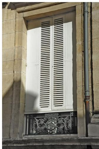
Au rez-de-chaussée, des volets pliants sans débattement sur le trottoir. A noter : pour l'isolation thermique et phonique une fenêtre intérieure (presqu'invisible depuis la rue) a été posée sans toucher à la fenêtre ancienne.
