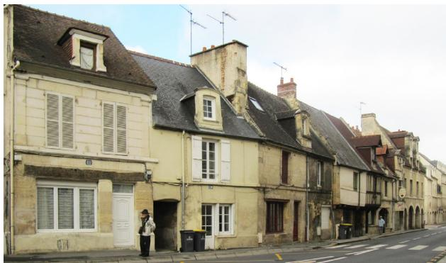
Série de maisons de même forme, mais de mode constructif différent : rez-de chaussée et étage en maçonnerie ou étage en encorbellement en pan de bois. 112 à 122 rue Caponière.
