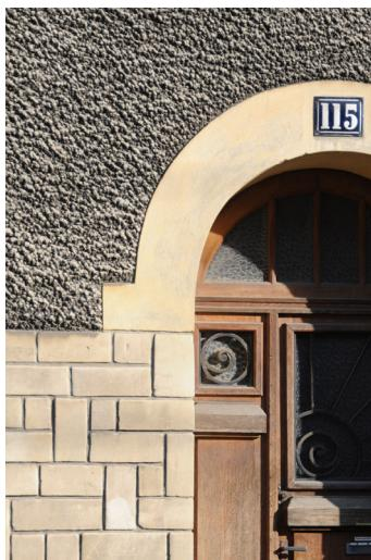
Pierre taillée, appareillée de manière non traditionnelle, arc en plein cintre en béton avec enduit ciment chaulé, enduit ciment projeté à la tyrolienne.
