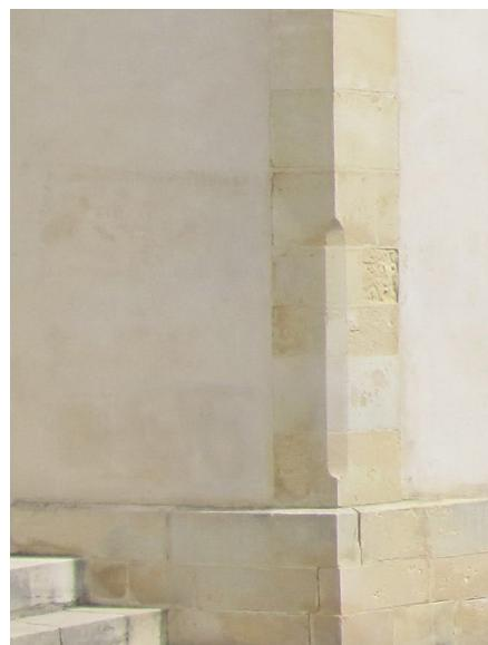
Enduit couvrant une maçonnerie de pierre et pierre de taille en chaîne d'angle.
