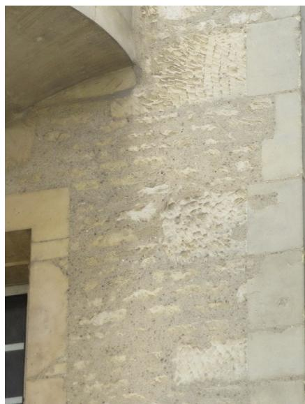
Enduit beurré à fleur sur une maçonnerie de moellonage.
