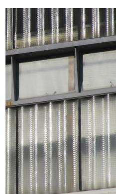
*Mur rideau en plaques de verre entre les éléments de structure en béton, Galeries Lafayette.*
