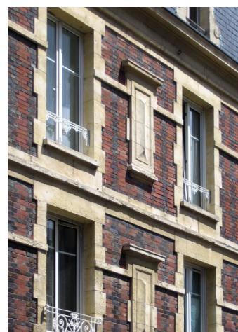
Structure béton et pierre, jeu de deux briques différents en tableau des baies, bandeaux très saillants en béton, enduit en attique.
