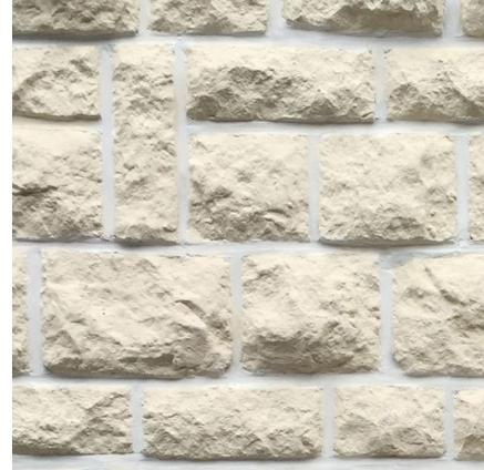
Finition layée (appareillage Reconstruction, non traditionnel).
