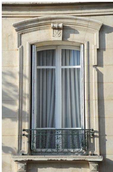
Style Classique XIXème. Encadrements moulurés, fenêtres à grands carreaux, volets pliants en tableau pour préserver la visibilité des moulures, garde-corps en fonte de l'industrie.
