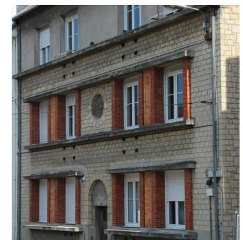
Structure béton et pierre, jeu de deux briques différents en tableau des baies, bandeaux très saillants en béton, enduit en attique.
