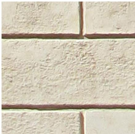
Finition en bossage (appareillage Reconstruction, non traditionnel)
