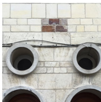
Incorporation d'un motif de pierres de couleur dans l'axe du trumeau entre les baies.
