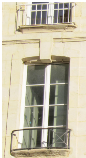
Garde-corps inférieur incomplet et supérieur non cohérent.
