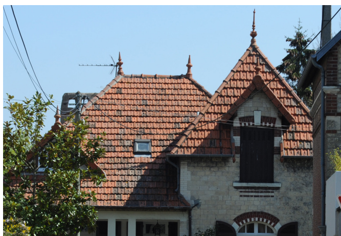
Couverture en tuiles mécaniques sur un pavillon «Entre-deux-guerres».
