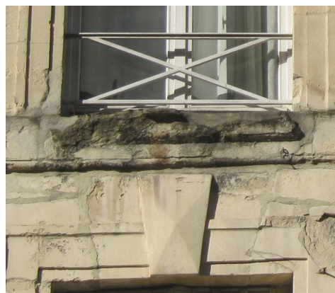
● Modénature en pierre de taille à réparer.
