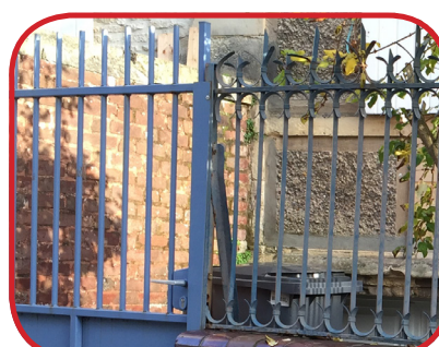
Détail d'une grille de style Art déco, conçue avec le mur en brique ; elle nécessite une protection antirouille et une peinture.
