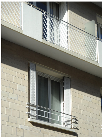
Deux exemples de mise en œuvre de profils d'acier à section carrée.
