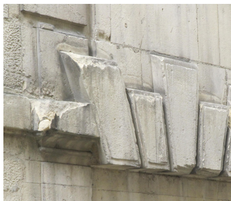
● Appui de fenêtre en pierre moulurée, dégradé, à restaurer.
