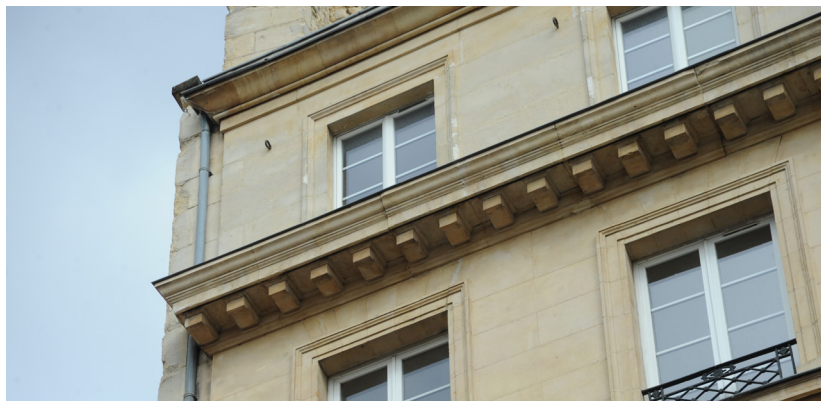
Large corniche débordante, soulignée de modillons, bandeau et moulures en pierre de taille de style Classique.
