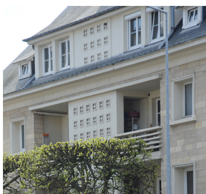
Claustras sur les balcons pour masquer un étendage, et lisses de béton en allège. A noter : le motif de claustra se prolonge en toiture.
