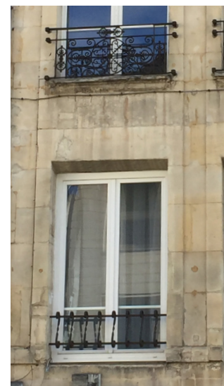
Garde-corps inférieur «à l'espagnole», non cohérent avec le garde-corps supérieur d'origine, en fonte.
