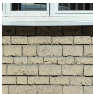
Finition éclatée, lits de différentes épaisseurs, pierres de longueurs variées, joints en creux.
