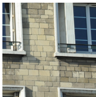
Finition rugueuse, lits de différentes épaisseurs, pierres de longueurs variées, joints légèrement creux.
