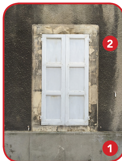
● Modénature en pierre de taille à réparer.
