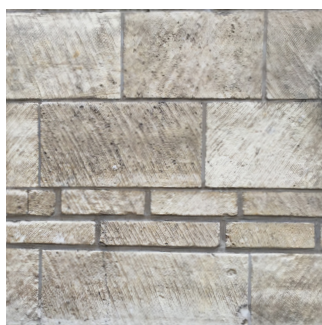
Finition striée, montage en lits d'épaisseurs contrastées, joints en léger creux.
