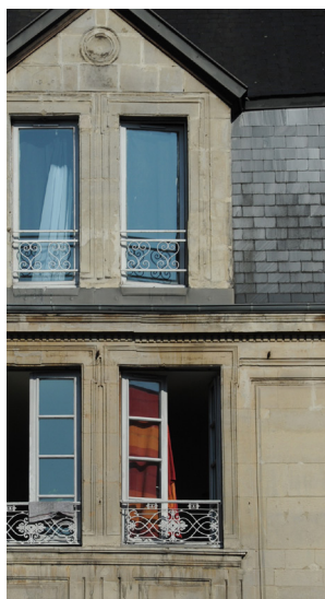
Garde-corps de lucarne non cohérents avec ceux de l'étage inférieur, d'origine.
