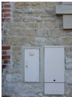
Coffrets de branchement Encastrement correct.
